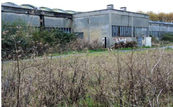
„Tunel“ pred premenou
