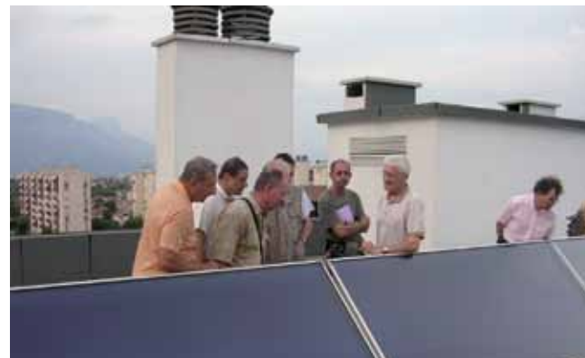
Solar vandvarmesystem, Echirrolles, Frankrig.
