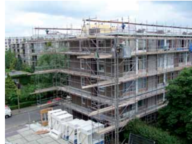
Social boligbyggeri renovering, Robijnhof, Utrecht, Holland.
