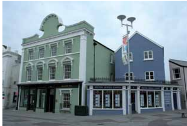
8-10 et 12 Durnaven Place, BTHIS avec détails architecturaux restaurés (fenêtres Sash, toiture en ardoise, mise à nu de la pierre, etc.), Bridgend, Royaume-Uni
