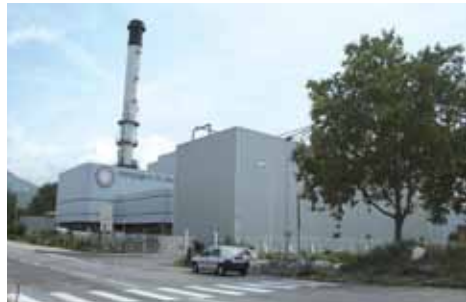
Compagnie de Chauffage de l'agglomération grenobloise, Grenoble, France.
