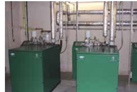
Machine SENERTEC « Dachs » à moteur électrique Cogen de 5 kW (Francfort, Allemagne)
