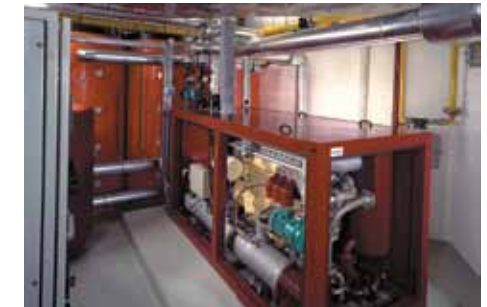
Moteur électrique de 50 kW géré par l'association des propriétaires de logements sociaux de Rödelheim (Francfort, Allemagne)
