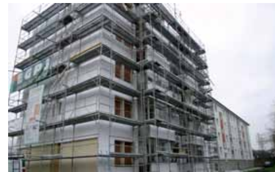
Programme de rénovation OPATB de niveau BBC « La Bruyère » à Echirolles (France)
