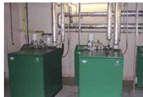
WKK-motor 5 kW elektrisch SENERTEC 'Dachs' machine, Frankfurt, Duitsland.
