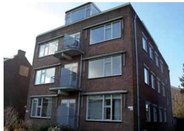
Renovatie sociale woningen met kleinschalige WKK, Tuinwijk, Utrecht, Nederland.
