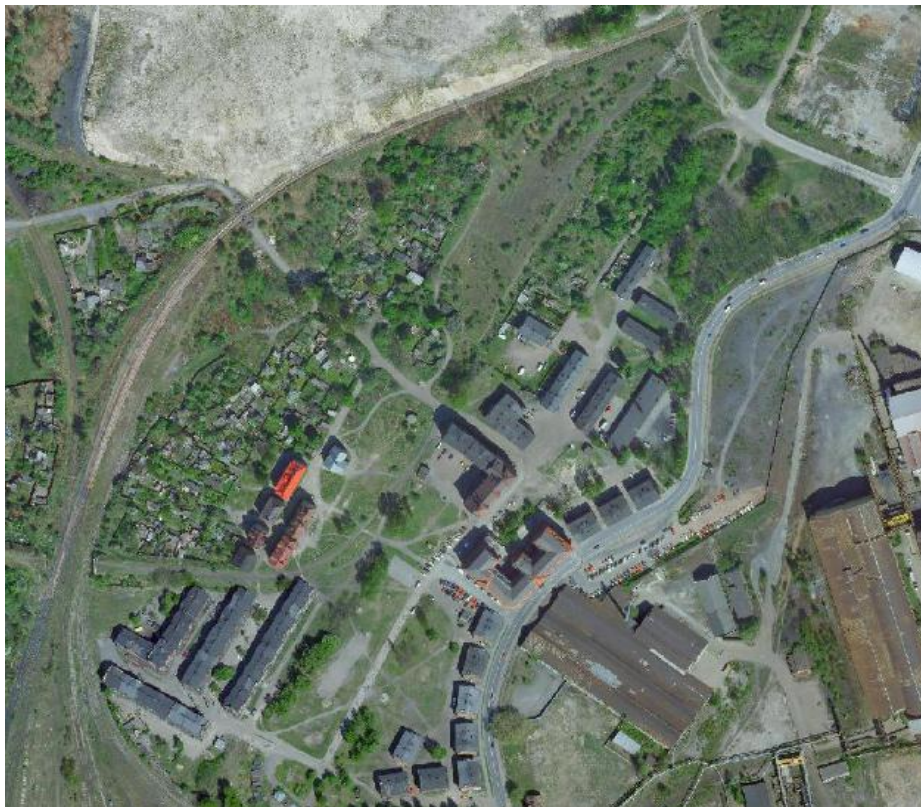
Obszar osiedla Kaufhaus przed rozpoczęciem prac modernizacyjnych
