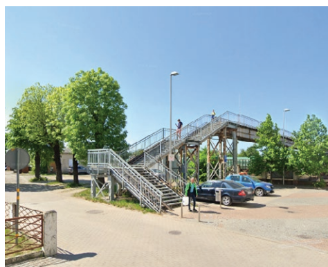
2-40. attēls. Uzeja uz dzelzceļa šķērsojumu Liepājas dzelzceļa stacijas pusē
