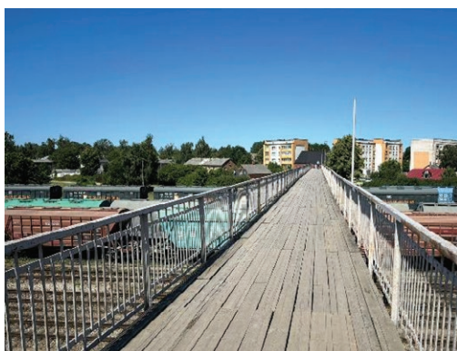
2-39. attēls. Dzelzceļa šķērsojuma klājs pie Liepājas dzelzceļa stacijas Avots: Liepājas IMRP Autori
